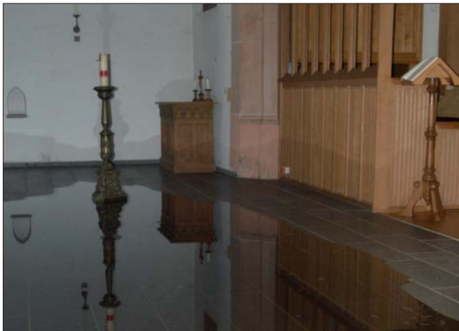
Unwetter führten Ende Juli zu Überschwemmungen im Inneren der Klosterkirche Mariawald.
