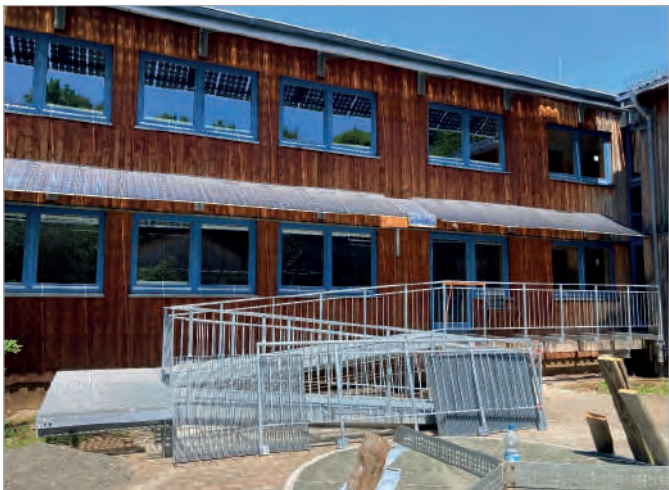
Ferner wurde mit der Entkernung der Sanitärräume im JWH im vergangenen Jahr begonnen.
