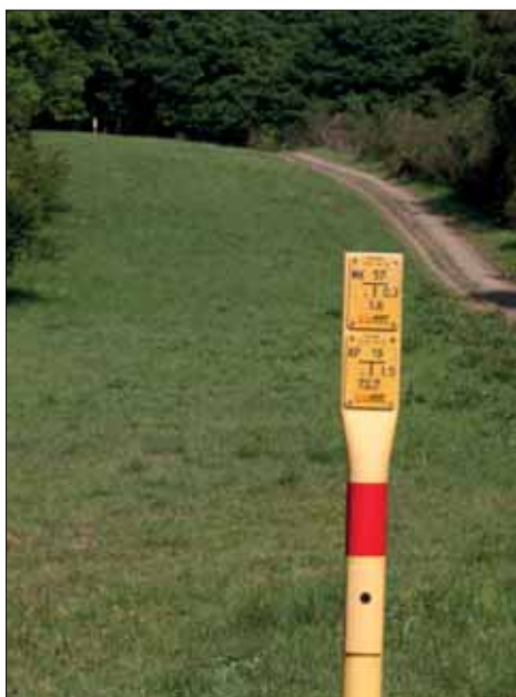
Abbildung 337: Das Teilgebiet Hetzingen quert neben einer Strom- und Wasserleitung eine Ferngasleitung (Foto: Andreas Pardey)
