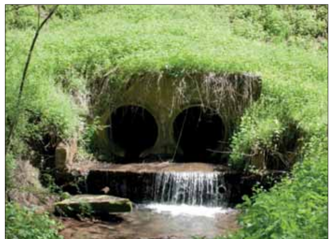
Abbildung 152: Beeinträchtigende Bachverrohrungen wie hier im Helingsbach werden sukzessive z. B. im Rahmen von LIFE-Projekten zurückgebaut (Foto: Andreas Pardey)
