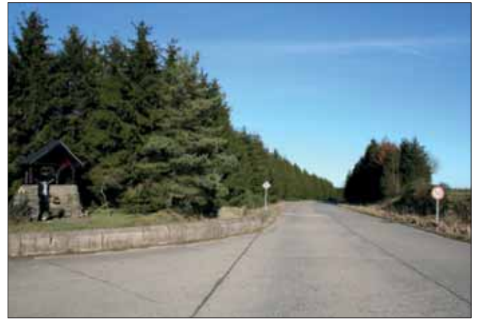
Abbildung 50: Planungen einer Umgehungsstraße für Dreiborn auf der Trasse der Panzerstraße werden nicht weiter verfolgt (Foto: Andreas Pardey)
