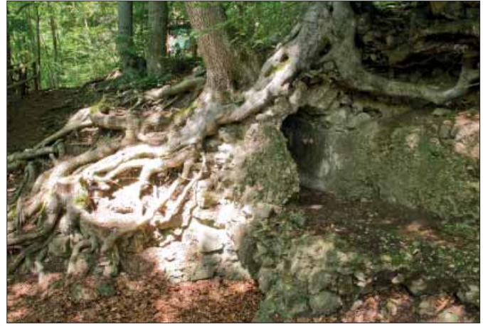
Abbildung 6: Reste der römischen Wasserleitung bei Kall-Urft (Foto: Andreas Pardey)
