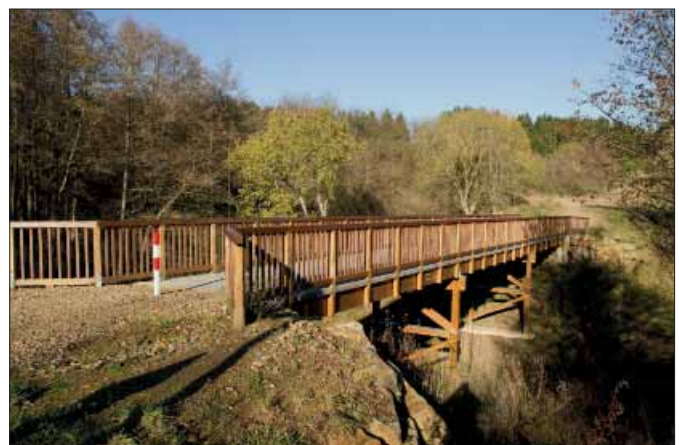
Abbildung 428: Das Life+-Projekt „Wald-Wasser-Wildnis“ (hier: Ersetzen eines Dammes mit Bachverrohrung als Panzerüberfahrt durch eine Brücke im Helingsbachtal) ist ein Beispiel für ein erfolgreiches Kooperationsprojekt der NLPV Eifel mit den Biologischen Stationen (Foto: Andreas Pardey)
