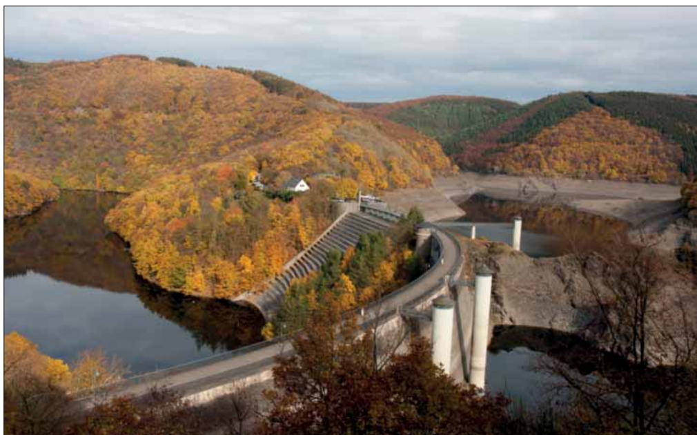
Abbildung 315: Die zwischen 1900 und 1905 errichtete Urfttalsperrenmauer trennt die Talsperre vom unterhalb liegenden Urftarm des Obersees (Foto: Andreas Pardey)
