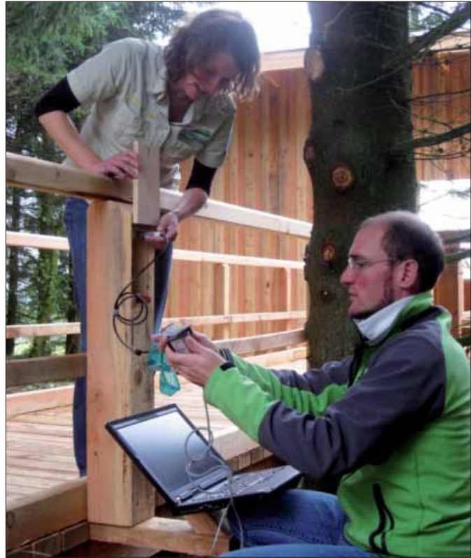
Abbildung 341: An der Rothirsch-Empore wird ein Besucherzählgerät installiert (Foto: NLPV Eifel)
