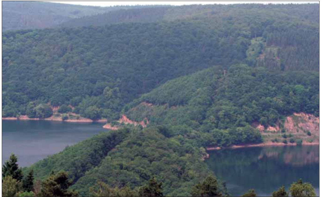
Abbildung 336: Die durch eine von höheren Bäumen offengehaltene Schneise verlaufende Stromleitung vom Kermeter über die Urfttalsperre zur Anlage Vogelsang stellt eine erhebliche Beeinträchtigung dar (Foto: Andreas Pardey)
