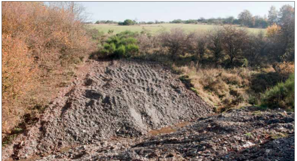
Abbildung 99: Beim Rückbau militärischer Überfahrten auf der Dreiborner Hochfläche wurde schadstoffbelastete Schlacken festgestellt (Foto: Andreas Pardey)
