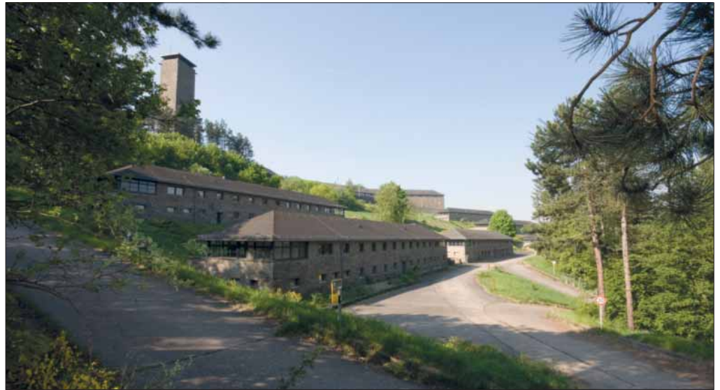
Abbildung 397: Die sogenannte „Ordensburg Vogelsang“ wurde in den 30er Jahren des letzten Jahrhunderts nach Plänen des Kölner Architekten Clemens Klotz errichtet (Foto: Andreas Pardey)
