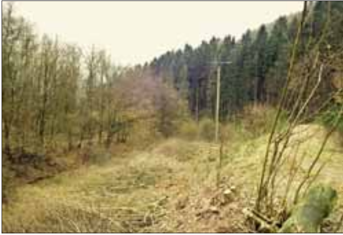
Abb. 89: Leitungstrassen (Lompigtal südlich Schleiden-Wolfgarten) müssen durch periodische Unterhaltungsmaßnahmen frei gehalten werden und stellen Störungen des Landschaftsbildes sowie Gefahrenpunkte für die Tierwelt dar. (Foto: A. Pardey)
