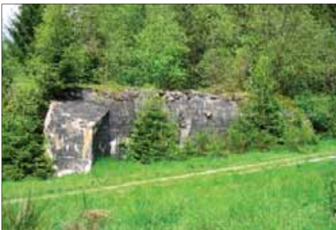
Abb. 43: Ausgewählte Bunker sollen vom Land übernommen, erhalten und verkehrssicher verschlossen werden (Foto: A. Pardey)
