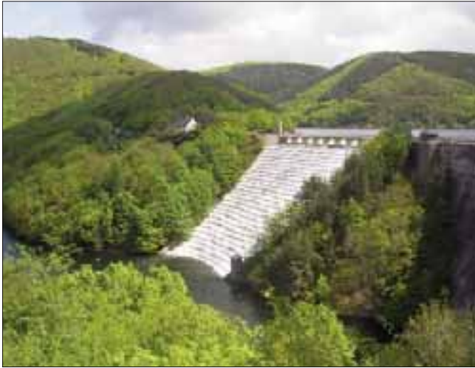
Abb. 80: Der Betrieb der dem Hochwasserschutz und der Stromerzeugung dienenden Urfttalsperre durch den Wasserverband Eifel-Rur stellt eine der wenigen genehmigten Nutzungsformen innerhalb des Nationalparks Eifel dar (Foto: M. Wetzel)
