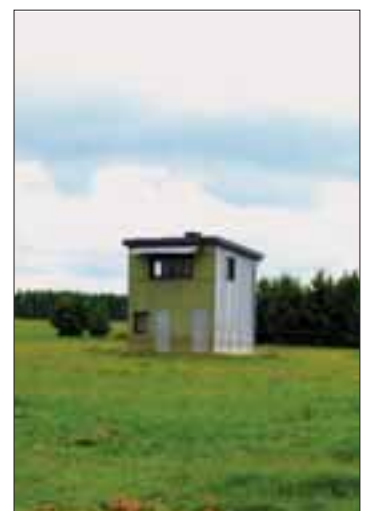
Abb. 34: Gebäude aus der Zeit der militärischen Nutzung der Dreiborner Hochfläche sollten i.d.R. entfernt werden (Foto: A. Pardey)
