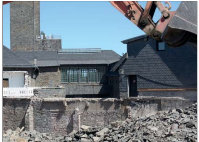
Im Adlerhof auf Vogelsang starteten umfangreiche Bauarbeiten, um dort die Architektur für das Nationalparkzentrum, die NS-Dokumentation und das Besucherzentrum zu schaffen.
