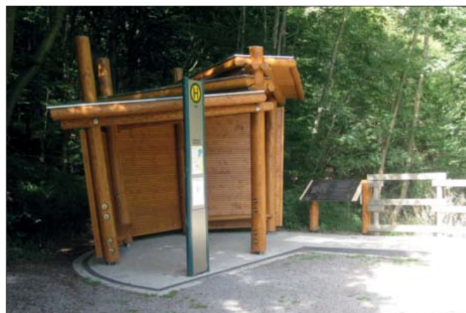
An der im Vorjahr vom Kreis Euskirchen eingerichteten barrierefreien Bushaltestelle „Haftenbach“ am Urfsee haben die Ranger der verwaltungseigenen Holzbauwerkstatt ein Wetterschutzdach ergänzt.
