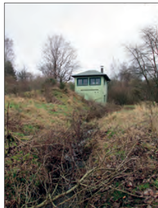
Auch das Beobachtungshaus am Helingsbach, ein ehemals militärisches Gebäude, konnte 2020 abgerissen werden.
