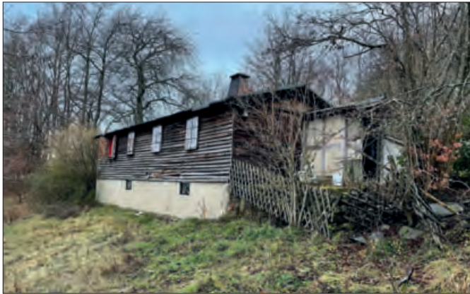
Die ehemalige Baracke an der Leykaul zählte zu den privaten Gebäude und wurde im Dezember abgerissen und das Material entfernt.
