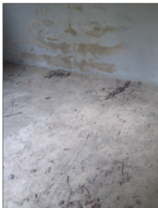
In einem Gebäudekeller waren drei Marder verhungert, weil sie den Ausweg nach draußen durch ein Belüftungsrohr nicht mehr gefunden haben.
