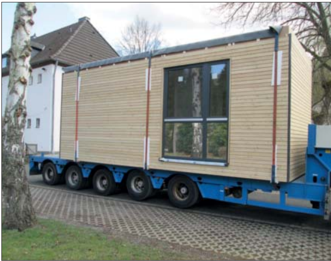
Einzeln wurden die fertigen Büromodule für die neuen Büroräume auf LKW angefahren.
