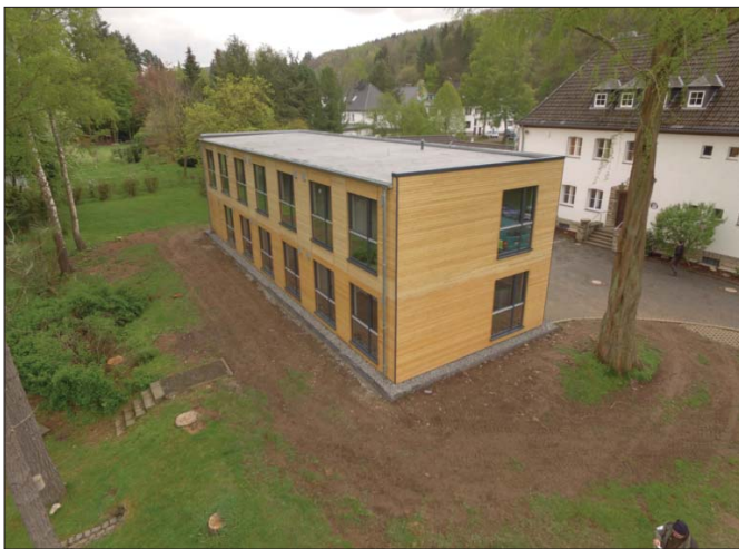
Moderne Holzmodulbauweise: Neue Büroräume für das Nationalparkforstamt Eifel.
