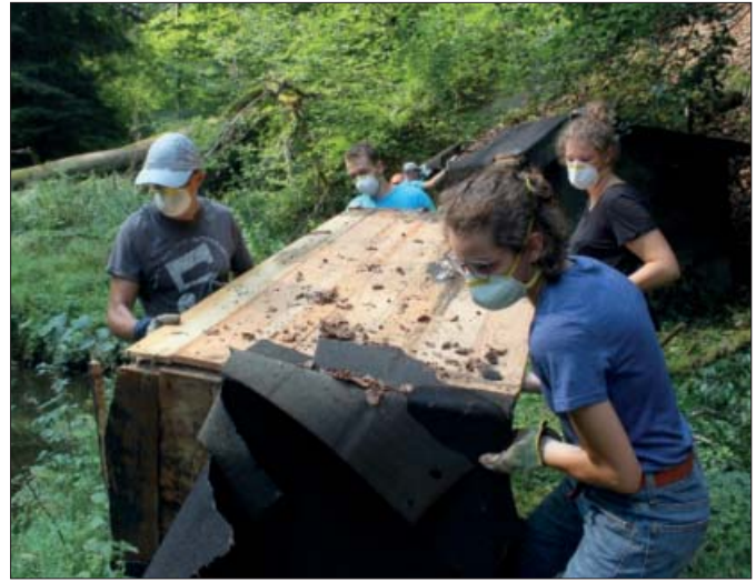
Die freiwilligen Helfer des Bergwaldprojektes beim Abbau einer kleinen Hütte auf einer Ankauffläche des Landes im Riffelsbachtal.
